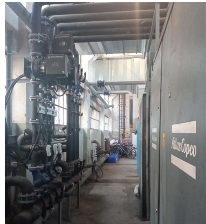
Iskorištenje otpadne topline kompresora
