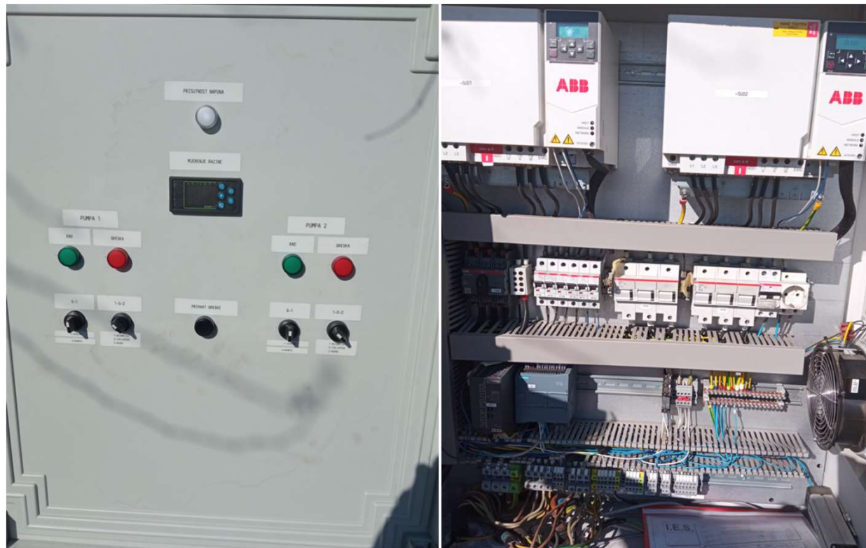
Frekventno upravljanje pumpama PS2
